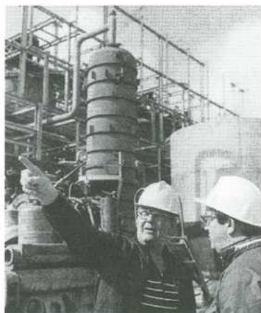
建設中のシンテック塩ビプラント
