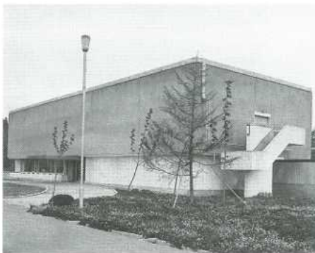
磯部工場の高純度シリコン工場（1号館）
