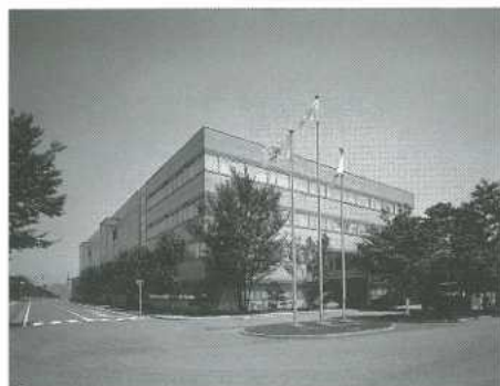
三益半導体工業の半導体事業部・上郊(かみさと)工場 (群馬県高崎市)
