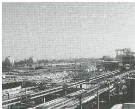
第2期工事完成間近のシンテック・アディス工場
