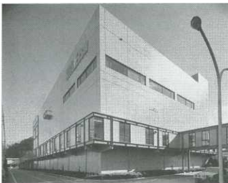
信越半導体炭部工場の新1号館
