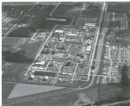
建設中のシンテック・ブラクマン工場
