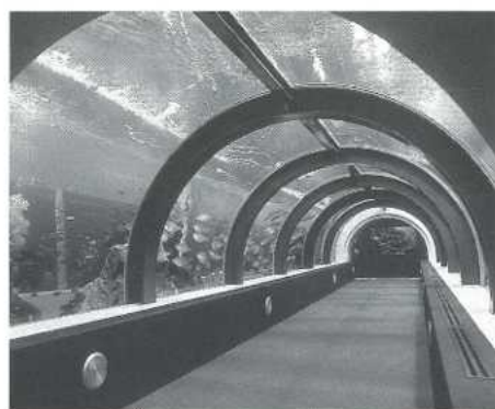
当社シリコーンが採用された浅虫水族館(青森県)のトンネル水槽
