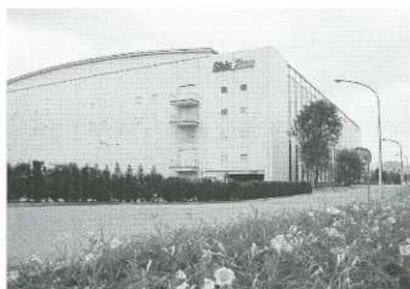
信越半導体白河工場に新設された300mmウエハー棟
