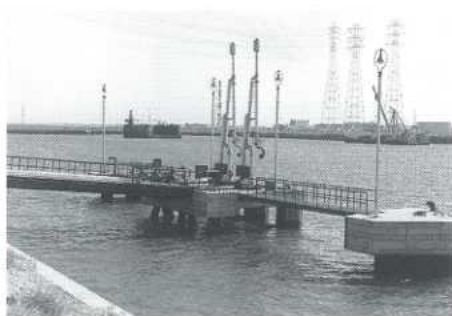
鹿島工場の塩ビモノマーバース
