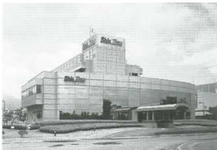
シリコーン電子材料技術研究所の新研究棟
