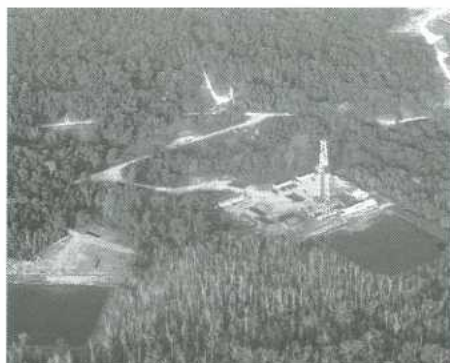
プラクマン新工場の出発原料となる塩水井戸掘削現場
