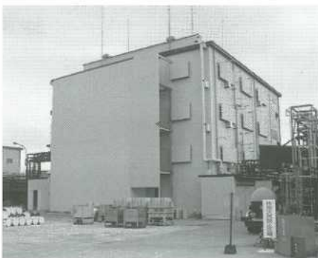
操業を再開したNR工場
